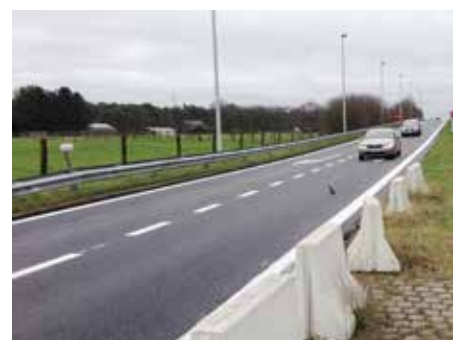
▲ In februari werd de afrit Berendrecht vernieuwd.
